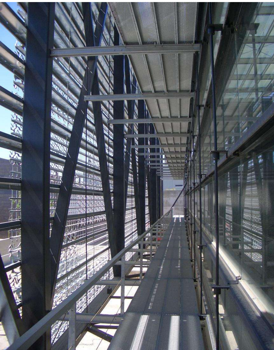
Vista dall'interno della struttura portante in acciaio e dei pannelli in acciaio zincato
